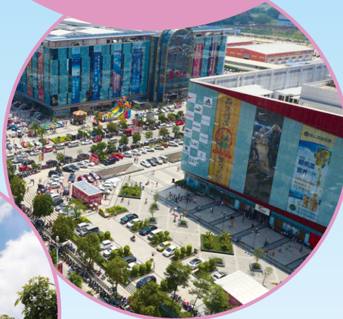
CSC Nanning in operation 營運中的南寧華南城
